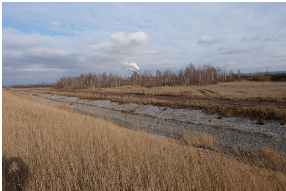
Рисунок 3. Зарастание разнотравной рудеральной и злаковой растительностью внешних откосов золоотвала № 2. Вид с точки (ТГ4).
