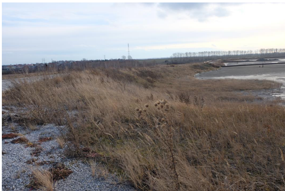
Рисунок 6. Заращение внутренних откосов золоотвала рудеральной растительностью на участке золоотвала ТГЗ.
